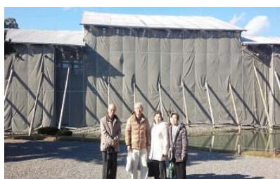
← 改修中の鳳凰堂
